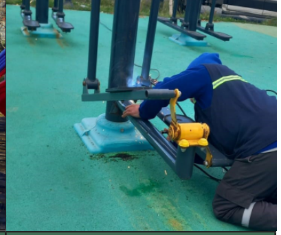
3.2) Fitness Grupları Onarım
