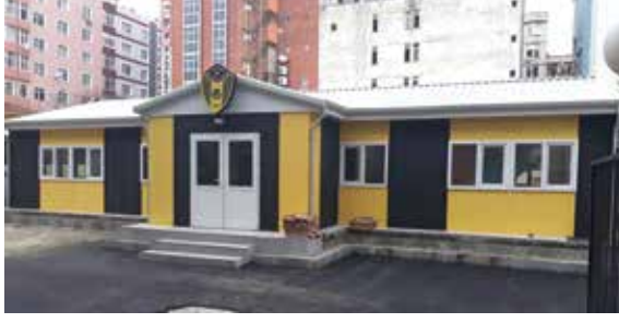
Merkez Mahallesi Avclar Spor Kulüp binası
