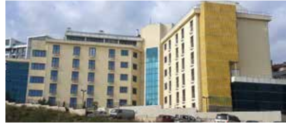
Sosyal Hizmet Binası
