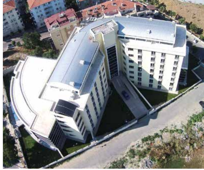
Sosyal Hizmet Binası
