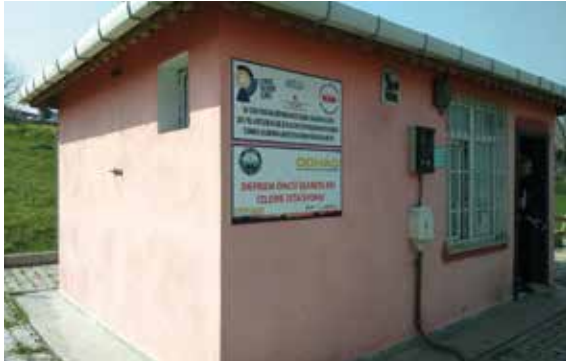
Deprem Öncü İşaretleri İzleme İstasyonu
