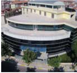
Sosyal Hizmet Binası
